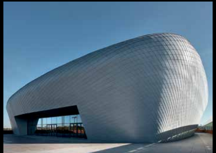
BREEAM: Docks Brussel - Architect: ART & BUILD Brussel (België)
